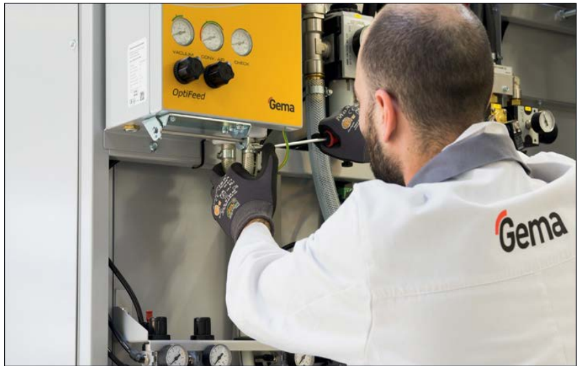
Photo 1 : Ingénieur Service Gema durant une opération de maintenance
